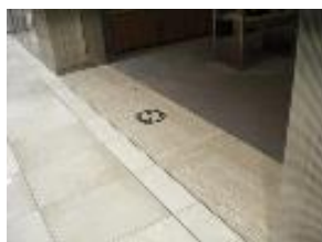
埋め込みアンテナ
